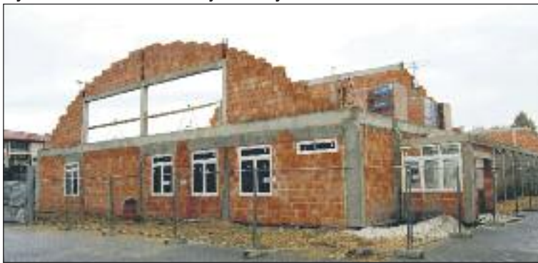
Budowa kompleksu oświatowo-sportowego przy ZS w Łapanowie - inwestycja powiatowa
