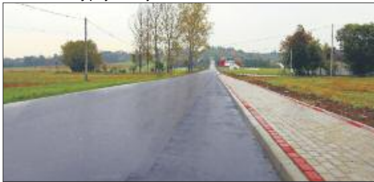
Schetynówka w Sobolowie w ciągu dróg powiatowych - inwestycja powiatowa
