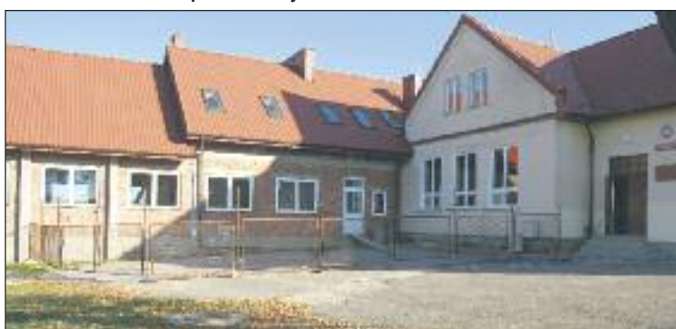
Budowa świetlicy przyszkolnej w Cichawce.
