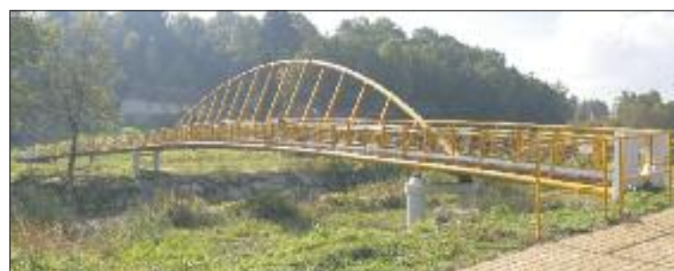
Nowa kładka w Łapanowie.
