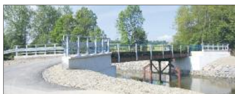
Most w Tarnawie po remoncie.
