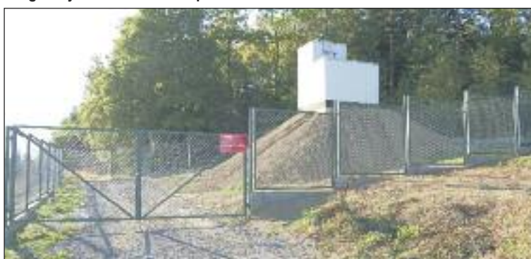
Zbiornik na wodę w Tarnawie wykonany w ramach wodociągowania gminy.
