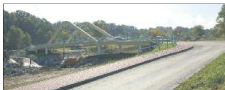
Nowa kładka pieszo-jezdna na drodze Łapanów – zalew.
