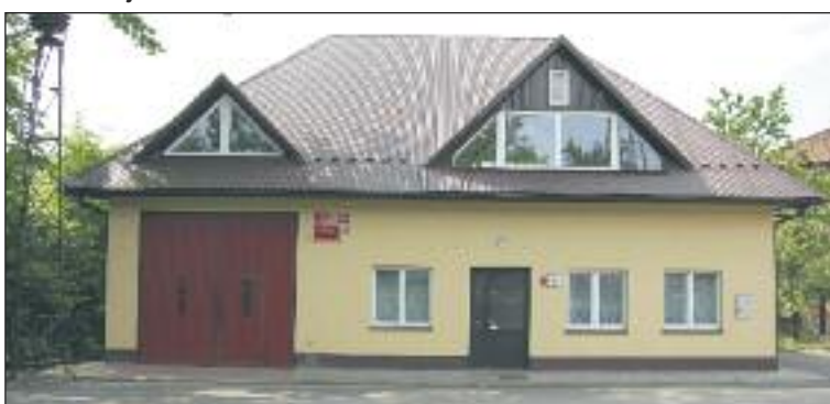
Wyremontowana świetlica wiejska w Zbydniowie.
