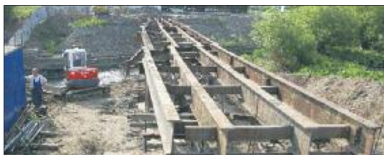
Most Boczów – Podwolica w trakcie odbudowy.
