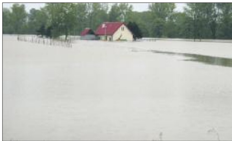
Zalana oczyszczalnia ścieków w Damienicach podczas powodzi w 2010 roku.
