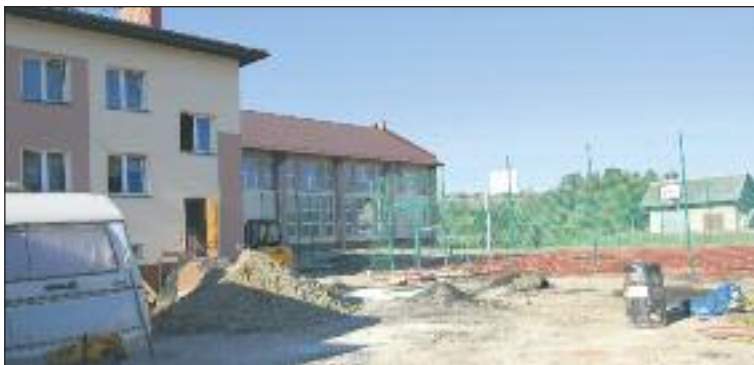
Budowa sali gimnastycznej i boiska przyszkolnego w Grabiu.
